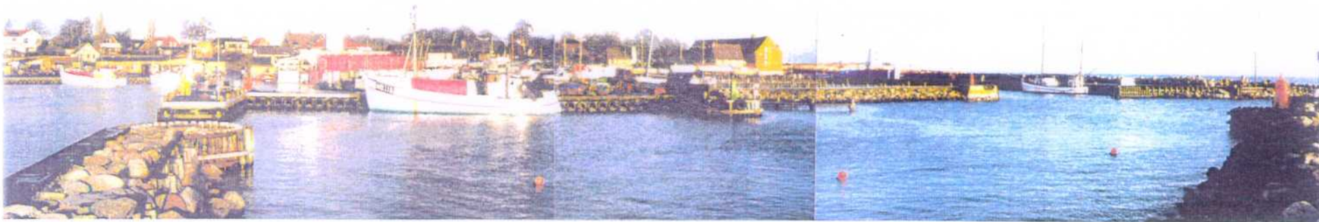
Eksisterende forhold. Midtermole og lystbådehavnen set fra sydmole.
